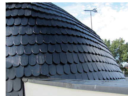
De nieuwe schaliën gemonteerd. Let op de windwijzer, initialen van de molenaars.
