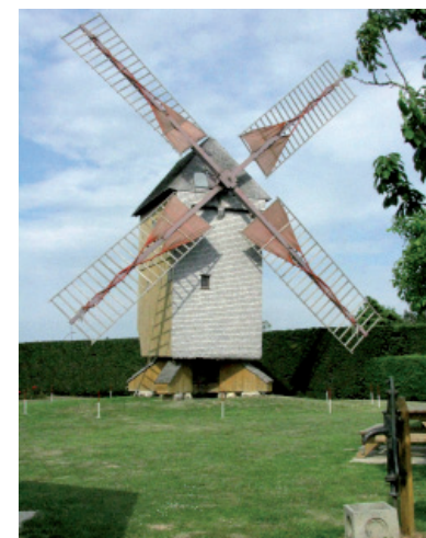
Molen met dwarsgetuigd wieksysteem in het dorpje Flacey Frankrijk. (W&R 2011 - 3)
