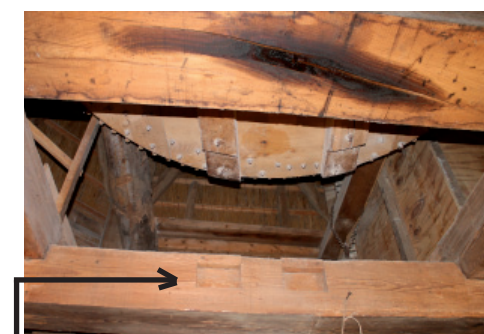
De generator komt op de plaats waar vroeger de tweede steenspil zat
