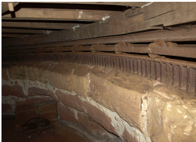
Engels kruiwerk met krans voor windroos
