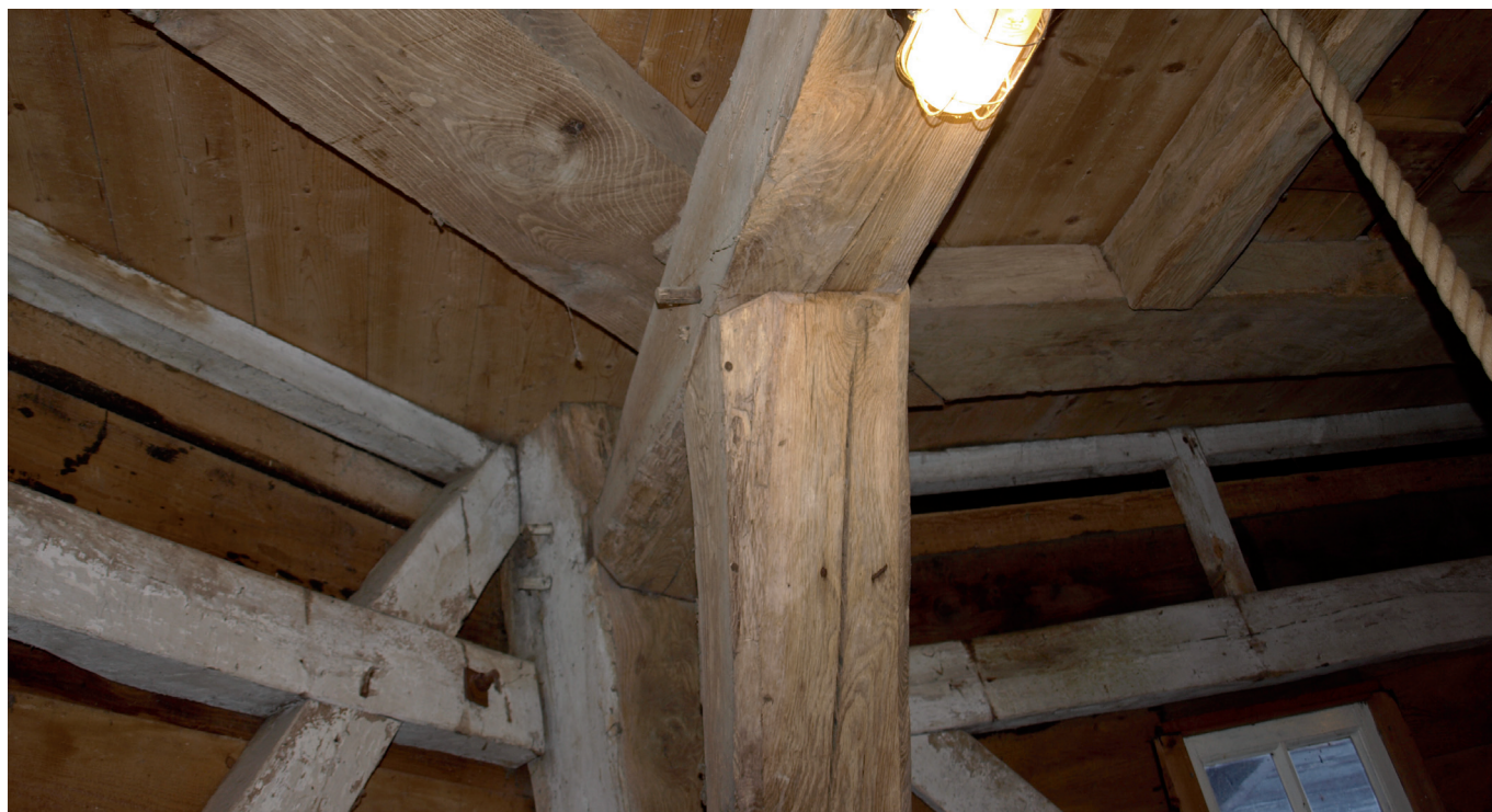
Opmerkelijk detail: Het tussentafelement waarop het bovenachtkant rust dat kleiner is van diameter dan het onderachtkant.
