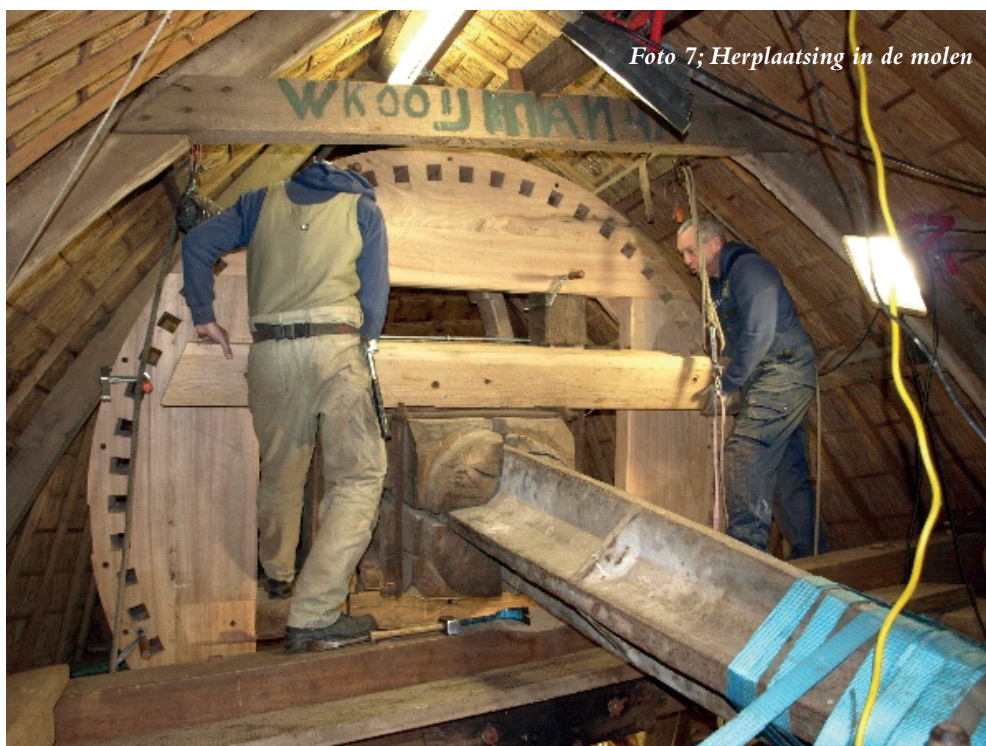
Foto 8; Kammen weer gestoken, ze worden ter plekke bijgewerkt.
