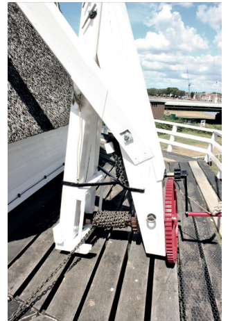
Staart na reparatie en schilderen
