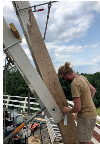
Staart in reparatie
